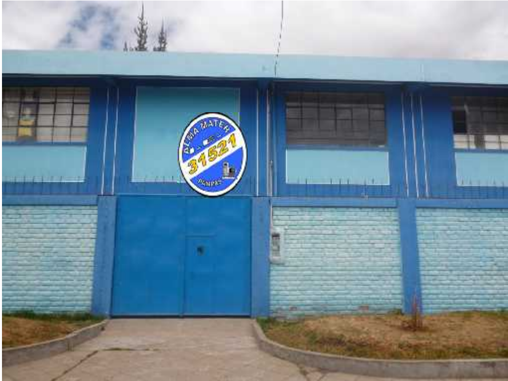
I.E. actual construida el año 2006
