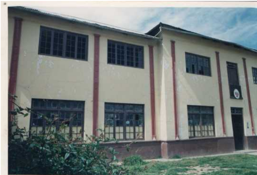
Escuela antigua construida en el año 1941, la cual se mantuvo hasta el año 2005
